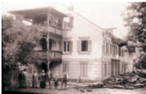
Leitner-Haus nach dem Brand.
