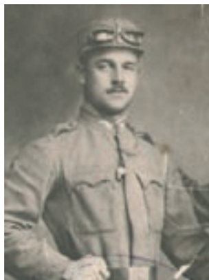
Luiteler Sepp in Fahreruniform der Zugspitzbahn.
